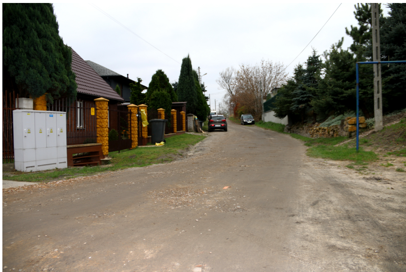
Ulica Zacisze przed inwestycją.
