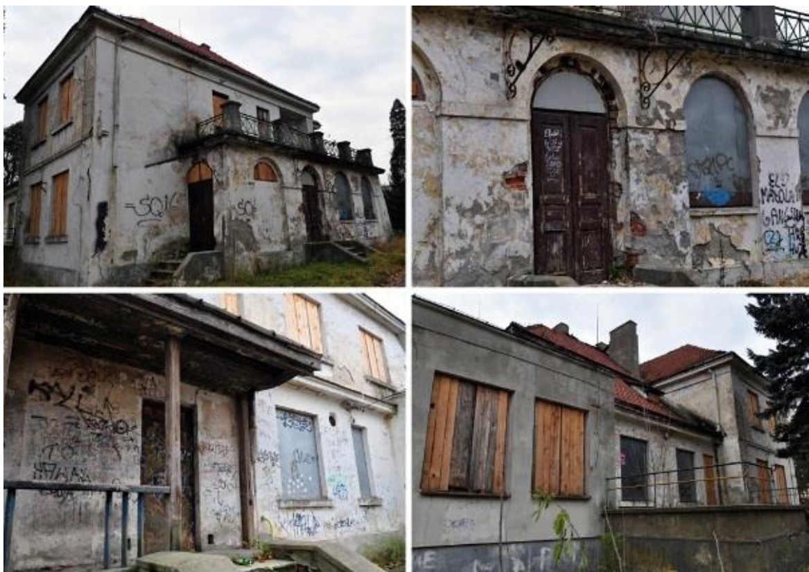
Ryc. nr 31. Budynek „Pałacyku”.
