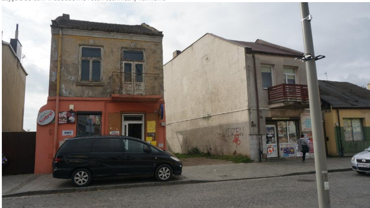
Zdjęcie 33 Luki w zabudowie i stan techniczny kamienic
