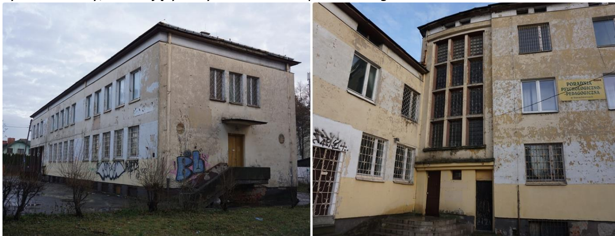
Ryc. 37. Dawny, niszczący budynek starostwa powiatowego
