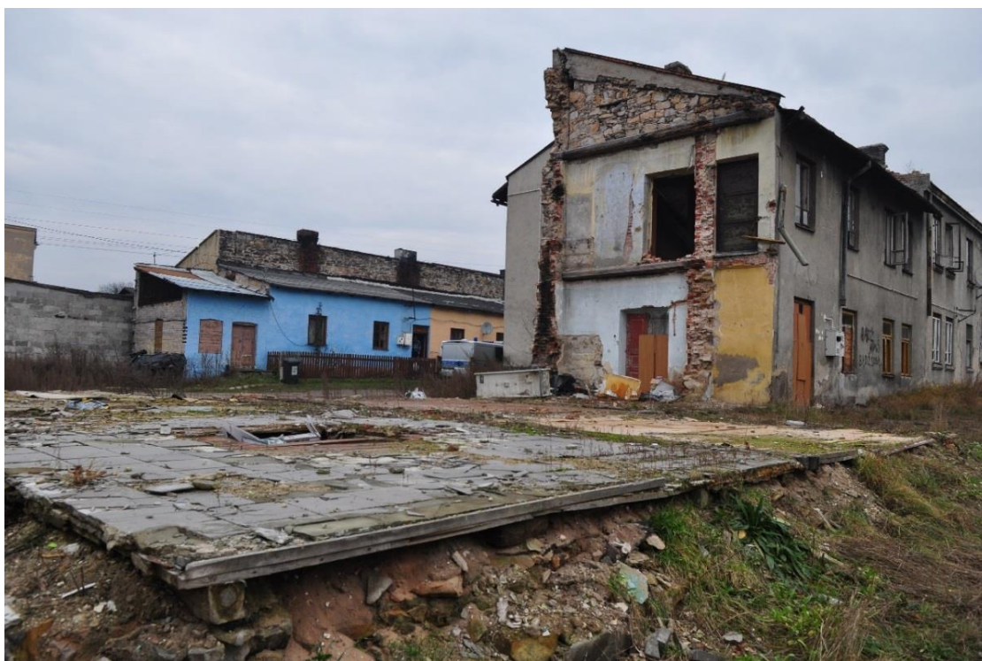
Ryc. 36. Niszczące budynki na Wierzbniku
