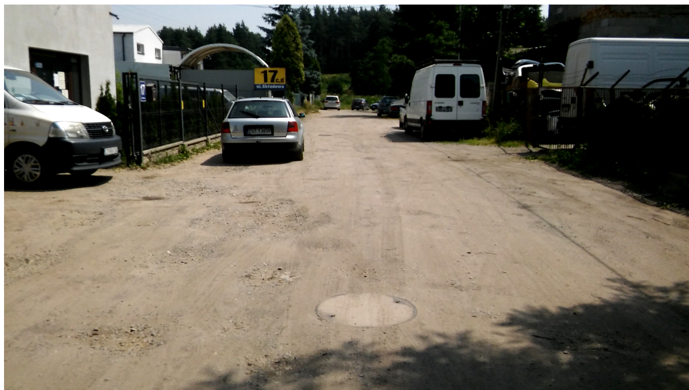
Odcinek ul. Składowej przed inwestycją...
